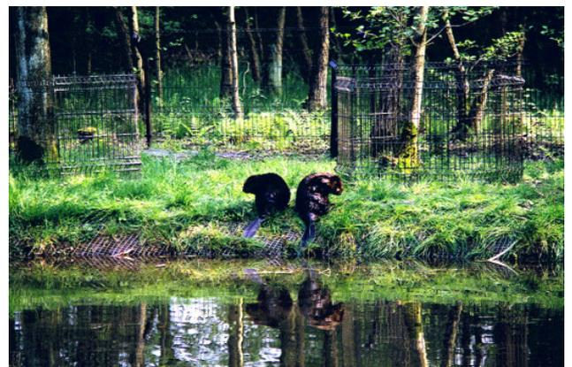
Bei allen niedrigen Raubwildgeheezäunen finden sie mit Elektrozaundrähten kombinierte, abgewinkelte, pulverbeschichtete Drahtgittermatten, die an einbetonierten Rechteckprofilpfählen befestigt sind. Diese Stabmatten-abwinkelung wurde von mir erfunden aber leider nicht zum Patent angemeldet.
